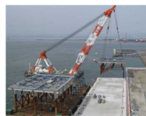
ジャケット設置の様子
