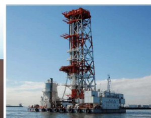
CDM船による海底の地盤改良
