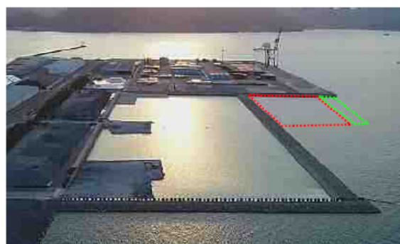
ふ頭用地施工状況 (H31.4.5)
