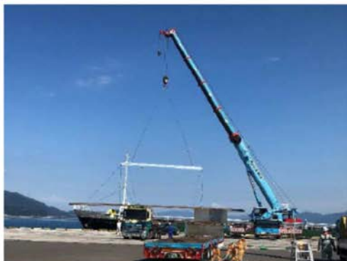
北陸新幹線レール陸揚げの様子【敦賀港】(R2.9.10)
