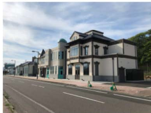
新築工事が進む新ムゼウム
