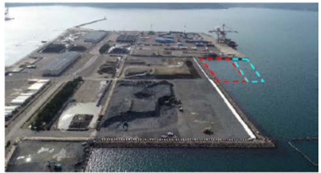
ふ頭用地施工状況(R2.3.18)
