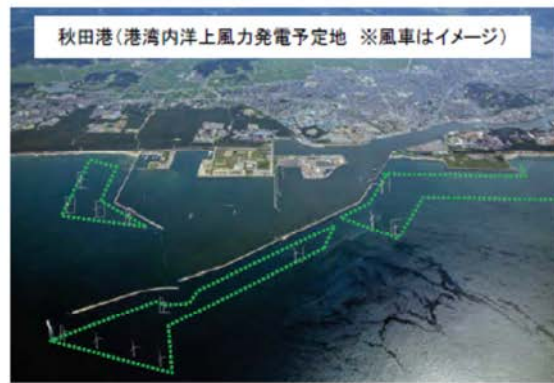
秋田港飯島地区(写真提供:秋田洋上風力発電株式会社)
