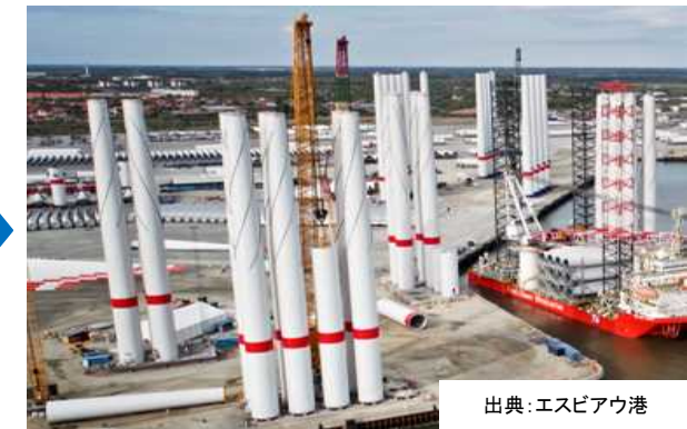
3. タワー組み立て
