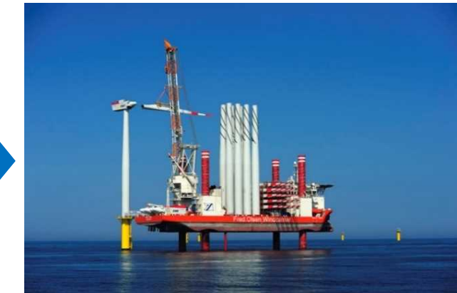
6. SEP船による洋上工事
