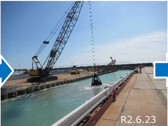
事前混合処理土投入
