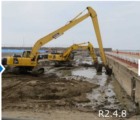
岸壁裏込部撤去
