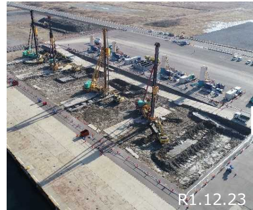
深層混合処理
