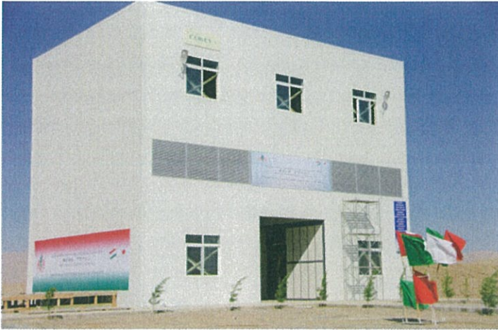
タジキスタン ハトロン州工場
